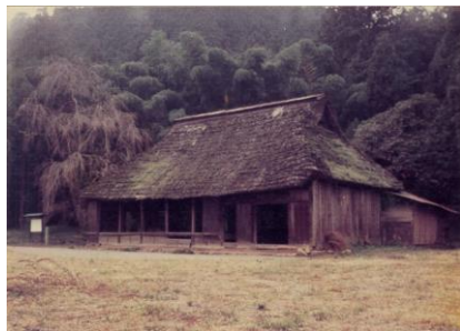
【解体調査再建前の国重文 高麗家住】
