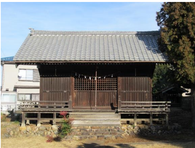
写真2 八幡神社 拝殿（日高市中鹿山鎮座）
